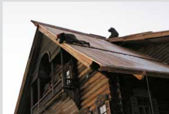
Ремонтно-профилактические работы на кровле дома Сергина
