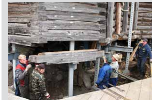
Демонтаж нижнего (7-го) реставрационного пояса сруба Преображенской церкви
