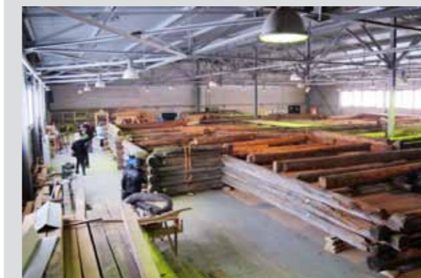
Сборка нижнего (7-го) пояса в Реставрационном комплексе
