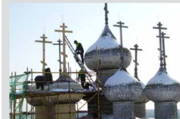
Реставрация глав Покровской церкви
