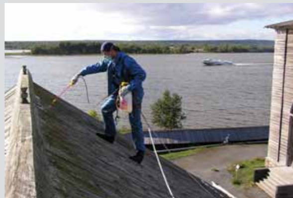
Обработка кровли Покровской церкви антисептиком
